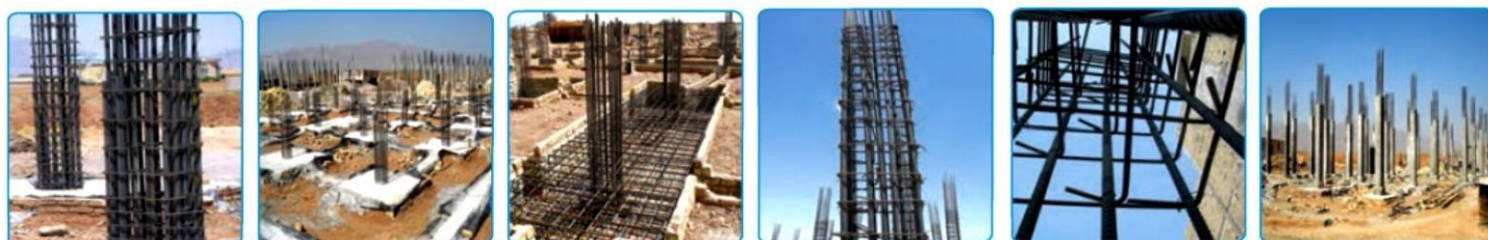
شکل ۷-۱۶- بتن ریزی ستون
