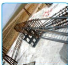
شکل ۷-۲۳. آماده کردن میلگردهای تیر روی زمین
