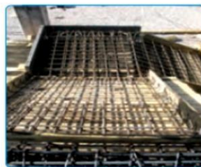
شکل ۷-۳۷- اجرای میلگردهای تال پله
