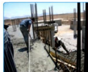
شکل ۷-۴۲- بتن ریزی تال پله
