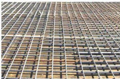
اجرای مش تحتانی
