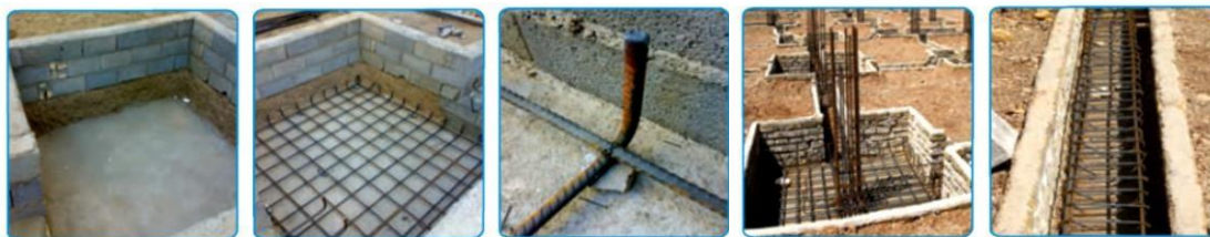
شکل ۷-۱- آماده سازی کف پی
