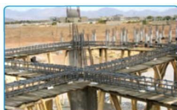
شکل ۷-۲۷. رعایت فاصله پوشش بتنی در کف
