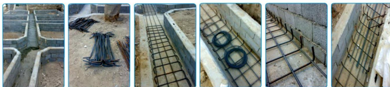
شکل ۷-۶- آماده سازی کف پی
