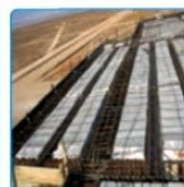
شکل ۷-۳۳- اجرای کنسول ها
