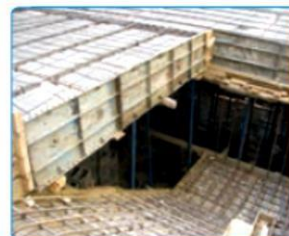
شکل ۷-۴۰- اجرای میلگردهای تال پله
