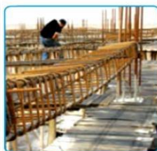
شکل ۷-۲۴. تنظیم فاصله بین خاموت‌ها
