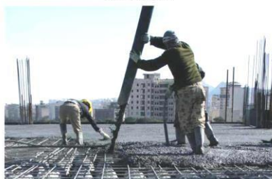
بتن ریزی و ویبره
