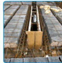
شکل ۷-۳۰- اجرای پاشودر سقف
