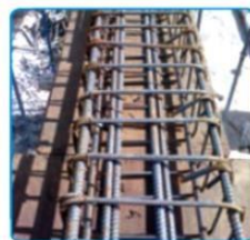
شکل ۷-۲۵. بستن خاموت‌ها با مفتول
