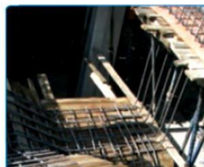
شکل ۷-۴۱- اجرای میلگردهای تال پله
