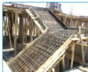
شکل ۷-۳۹- اجرای میلگردهای تال پله
