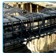
شکل ۷-۲۶. خم میلگردهای اصلی در انتهای محل قرارگیری
