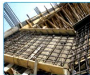
شکل ۷-۳۸- اجرای میلگردهای تال پله
